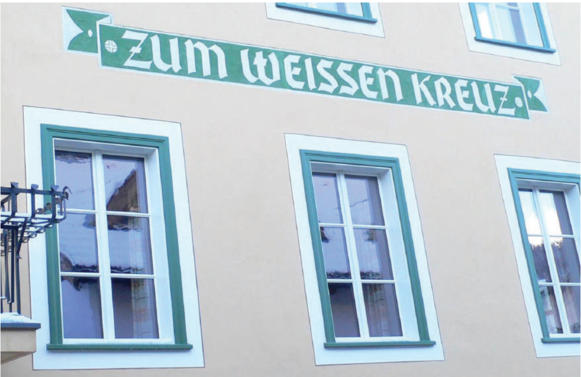
Ehem. Gasthaus „Weisses Kreuz“, Fließ bei Landeck Nachbau Fenster lt. Altbestand mit Außenstockrahmen und Faschen
