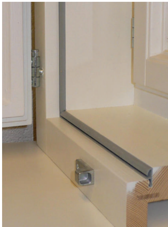
Einfräsen und montieren von ZP-Falzdichtungen
