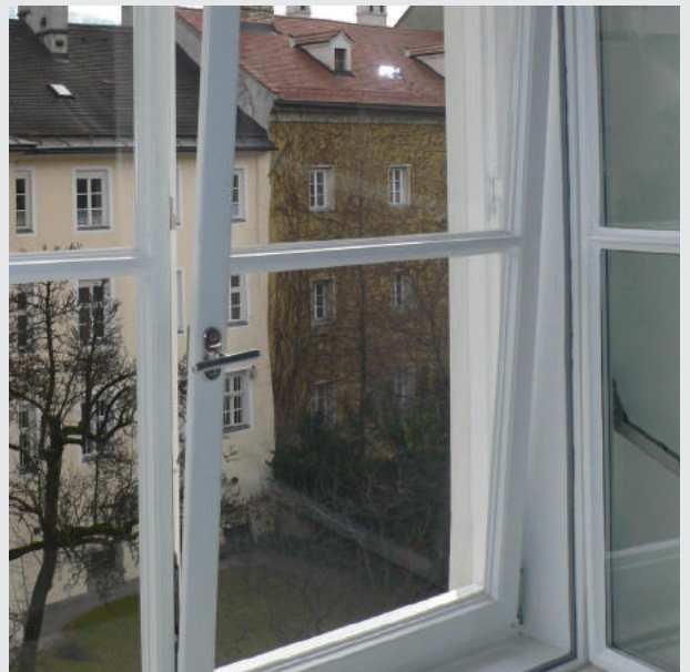
Drehkippfunktion bei geöffnetem Innenfenster möglich
