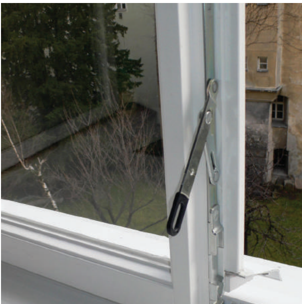
Umbau Mittelbund auf Verdecktliegenden Stulpflügelbeschlag
