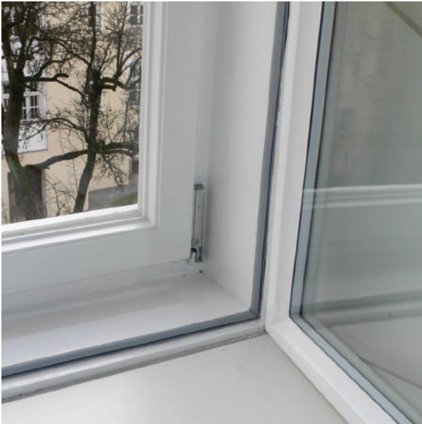
Umbau Außenflügel auf Verdecktliegenden Drehkipp-Beschlag
